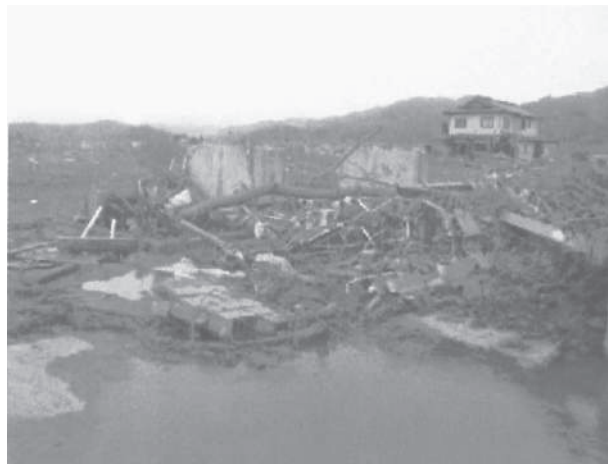
図3-2 貯槽・機械室入口付近（震災後）
